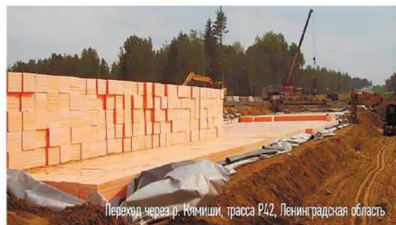
Рис. 9. Общий вид насыпи при строительстве перехода через реку Кямишу
