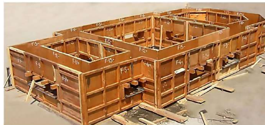
Рис. 7. Контрольная проверочная сборка фанерных щитов опалубки
