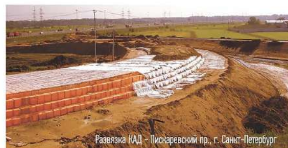
Рис. 10. Строительство развязки КАД – Пискаревский проспект
