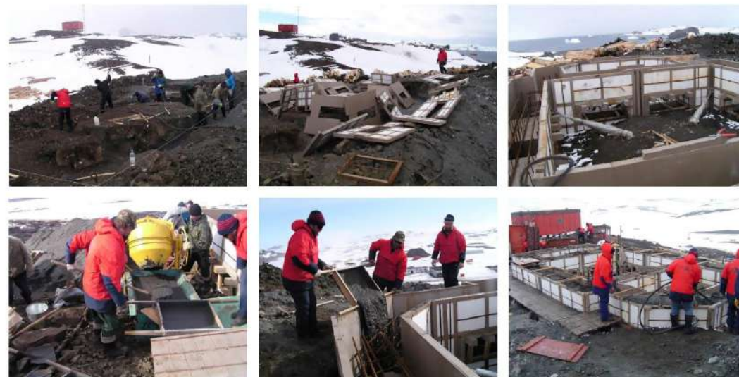
Рис. 8. Этапы изготовления монолитного фундамента храма
