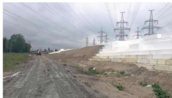
Рис. 8. Общий вид насыпи при строительстве продолжения Софийской улицы
